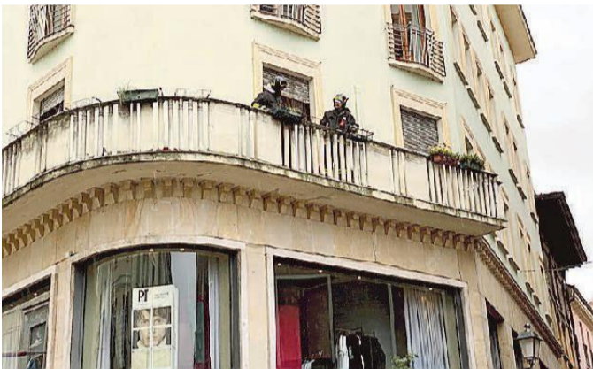
L'intervento dei vigili del fuoco in via Corridoni FOTO S. SACCANI
